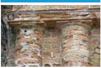
Particolari del rivestimento a intonaco bugnato con cantonale in risalto
