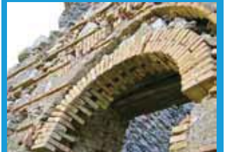
Particolari dell'apertura ad arco a tutto sesto e modanature sovrastanti con arco ogivale
