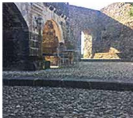
Rifacimento scala di accesso
