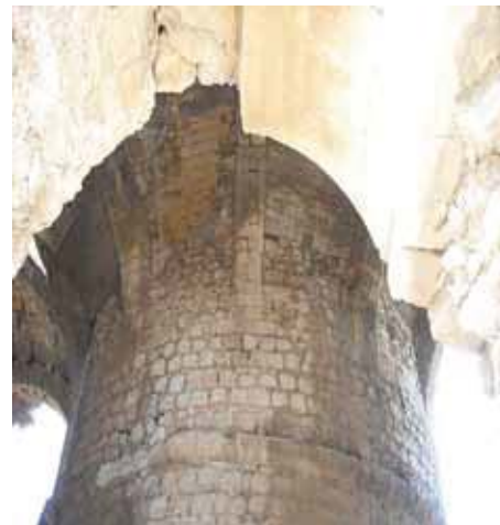
Struttura ad archi radianti della prima elevazione con cornice marcapiano
