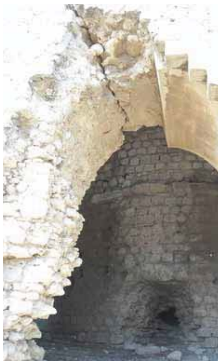
Particolare del corridoio anulare. Cornice marcapiano della prima elevazione in rapporto alla monofora e alla feritoia
